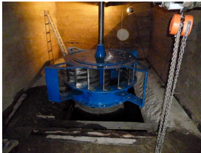
Slika 1. Vodena komora staroga mlina i nova turbina
