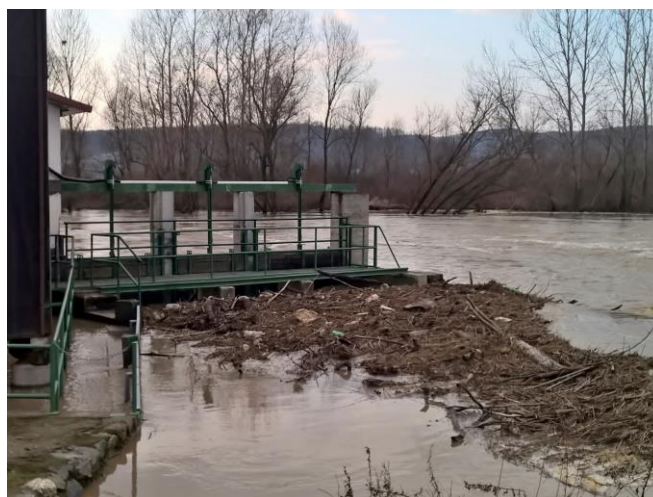
Slika 5. Ekstremno nakupljanje smeća na finoj rešetki
