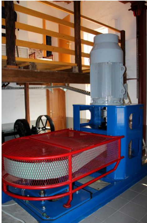
Slika 2. Remenski prijenos i generator
